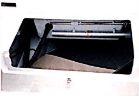
▲ Krmeni tambuč Najveće spremište je ono u krmenoj klupi. Unutra su glavni prekidač, dva akumulatora, filter goriva, a tu je i noga stola i jarbolet sa sidrenim svjetlom
