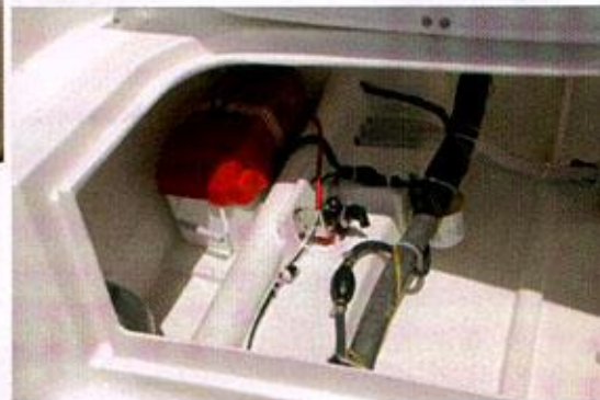
▲ Električna instalacija smještena je u sam desni ugao tako da je većina spremišta iskoristiva za smještaj stvari
